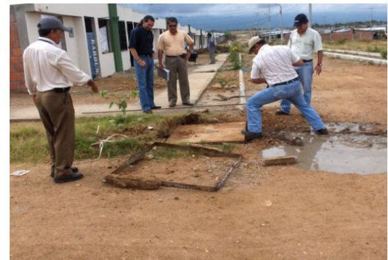
Tapa de la caja de válvulas de la red de acueducto que para al abrirla fue necesario destruirla
