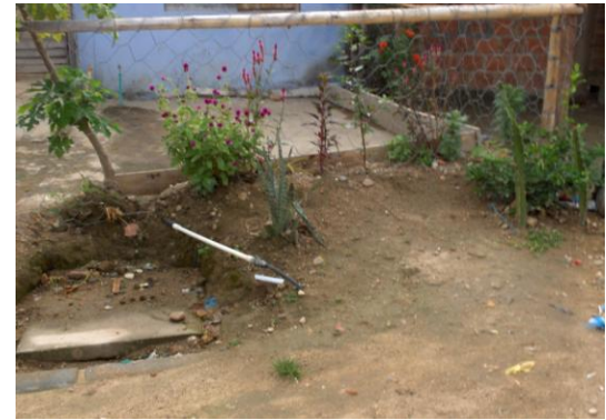
Tapa de la caja de válvulas de la red de acueducto que para al abrirla fue necesario destruirla
