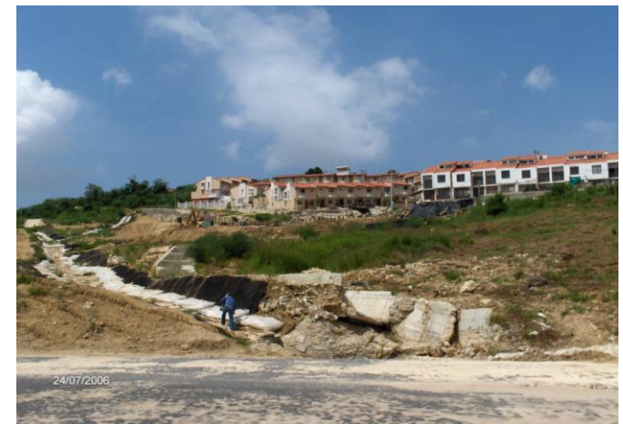
Estabilización de taludes ($1.365 M)
