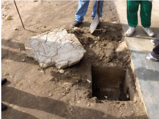
Cámara de inspección mal construida que no permite el ingreso de operario para mantenimiento
