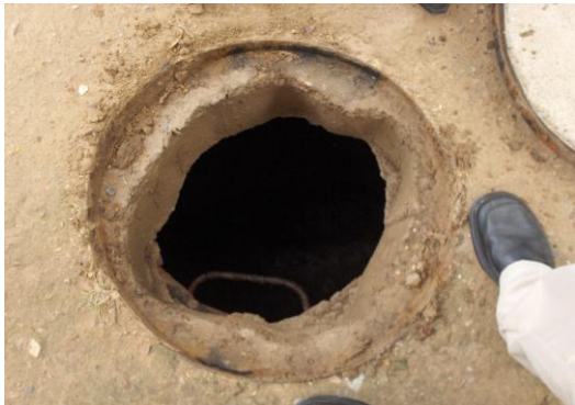
Cámara de inspección mal construida que no permite el ingreso de operario para mantenimiento
