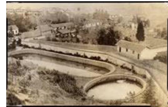
Acueducto de Egipto.
