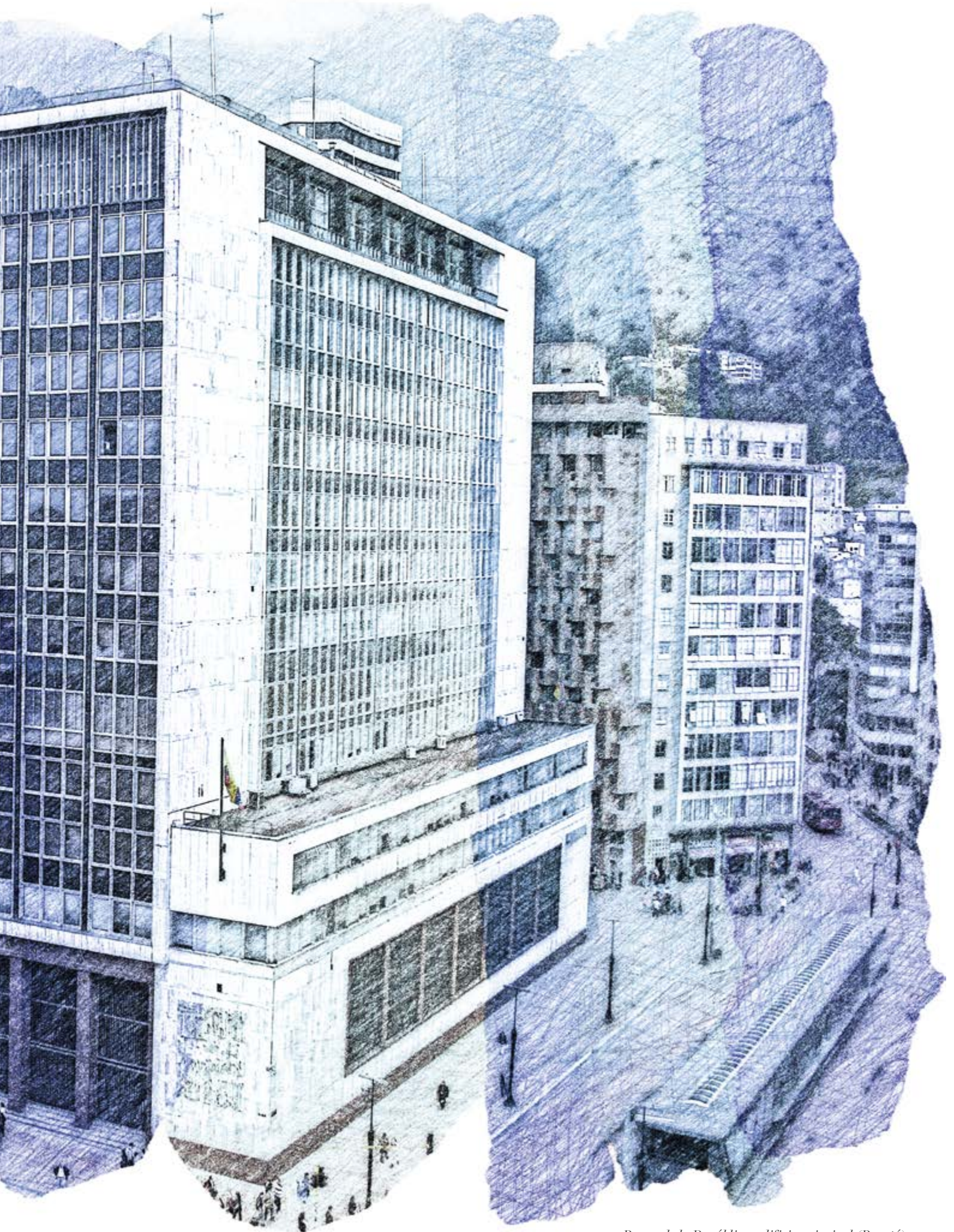
Banco de la República, edificio principal (Bogotá).
