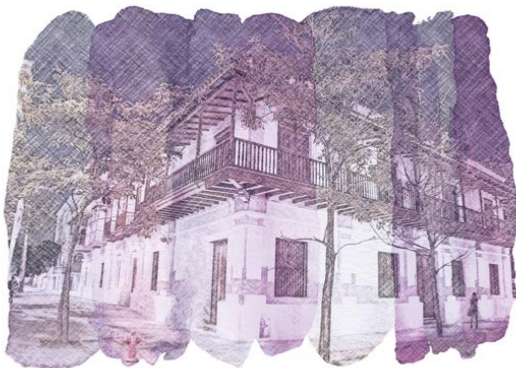
Renovación de la antigua Casa de la Aduana en Santa Marta.
