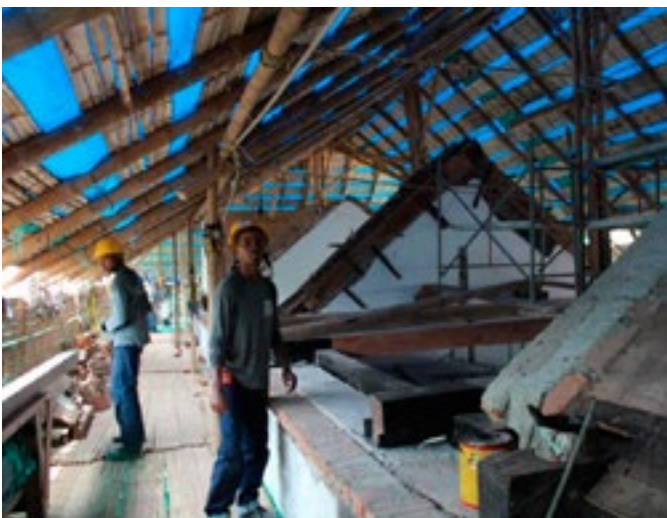
Recuperación de las cubiertas.
