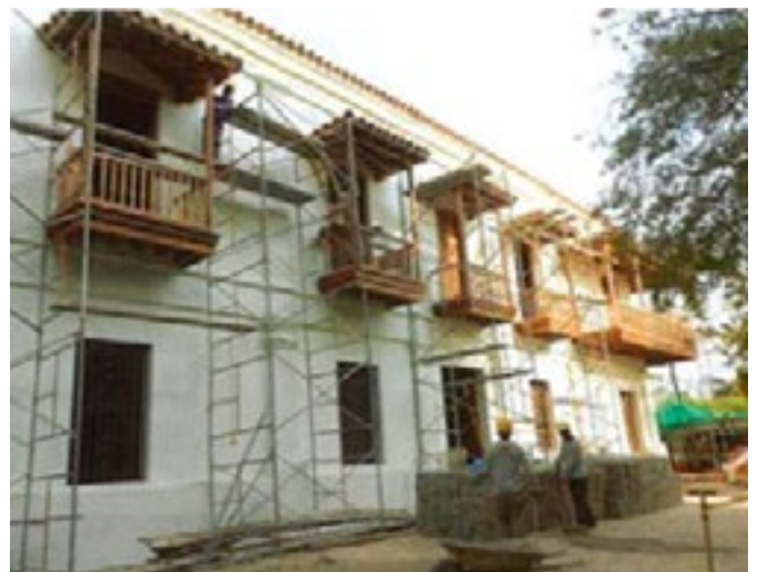
Trabajos de restauración de los balcones exteriores.
