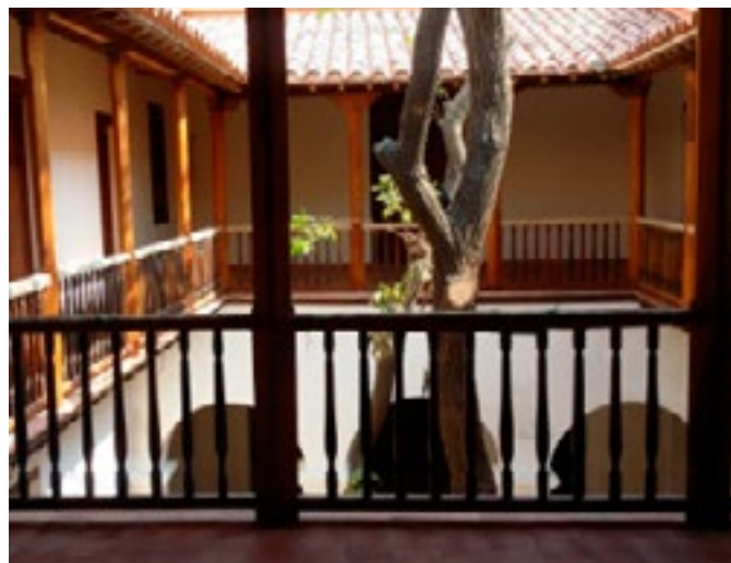
Vista interior de la Casa de la Aduana restaurada.
