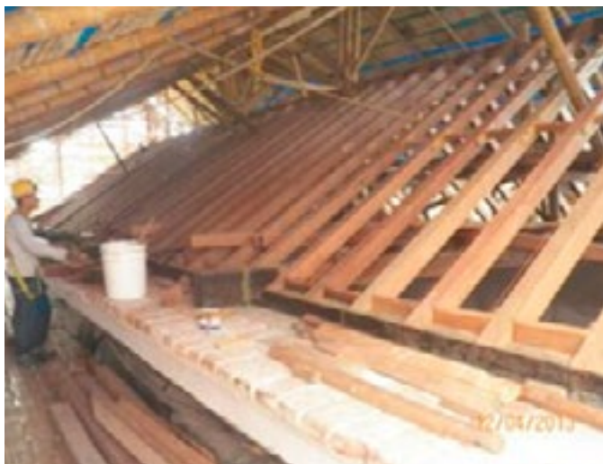
Especial cuidado para la restauración y aprovechamiento de las estructuras existentes de la Casa de la Aduana.
