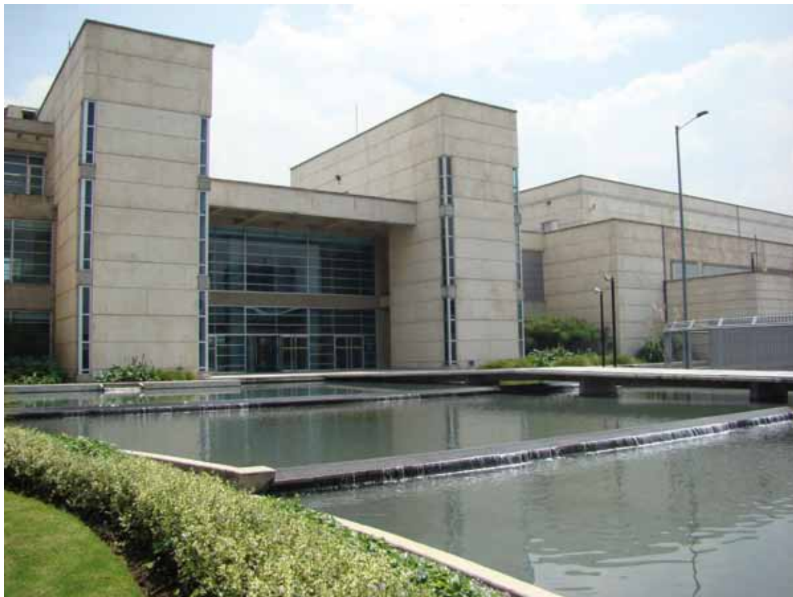
El espejo de agua de la Central de Efectivo permite el aprovechamiento de las aguas lluvias conduciéndolas a un tanque de almacenamiento, para ser utilizadas en el servicio de sanitarios, riego y reserva del sistema de control de incendio.
