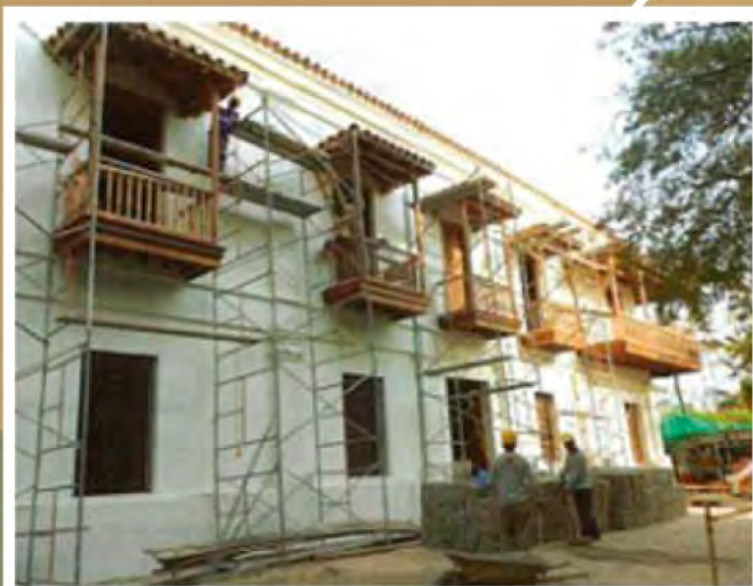
Trabajos de restauración de los balcones exteriores.
