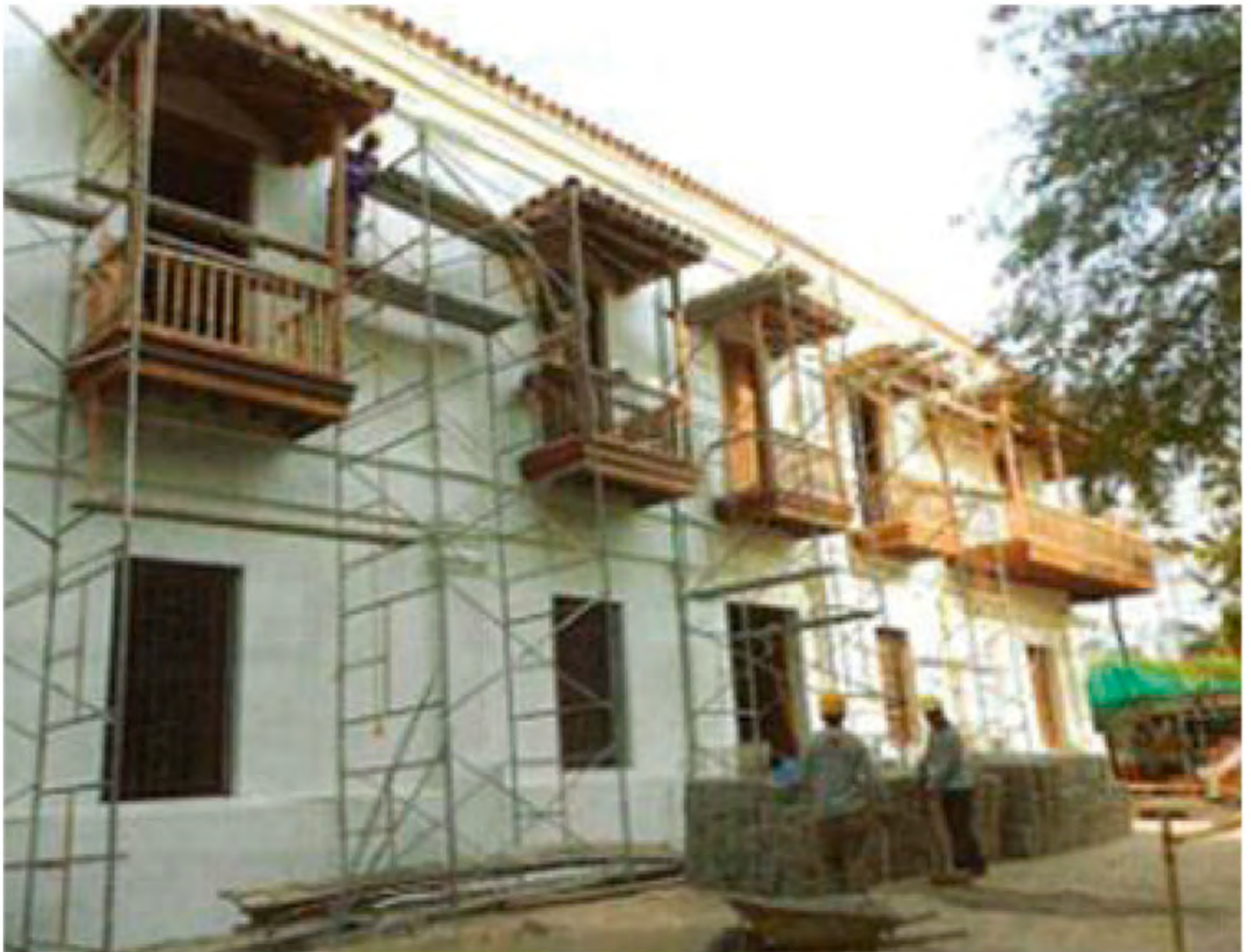
Trabajos de restauración de los balcones exteriores.
