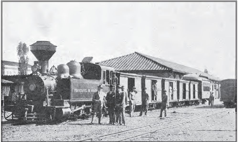
FIG. 12. ESTACIÓN DEL FERROCARRIL DE ANTIOQUIA EN MEDELLÍN
