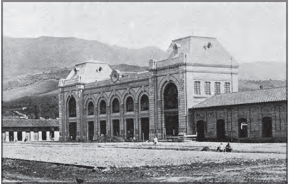
FIG. 11. ESTACIÓN DEL FERROCARRIL DE ANTIOQUIA EN MEDELLÍN
